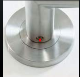
Störende Madenschraube sitzt unsichtbar auf der Griffunterseite.
