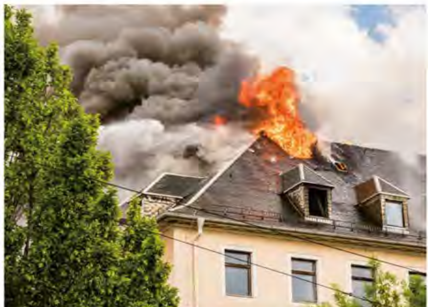
Gebäudebrände werden immer wieder durch Dacharbeiten verursacht.
