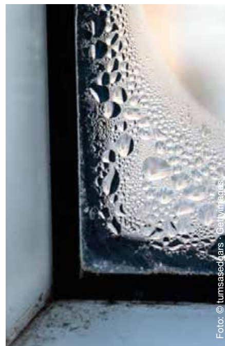
Schimmelpilz-Bildung und andere Feuchteschäden können die Bausubstanz schwer schädigen und sind gesundheitsgefährdend.
